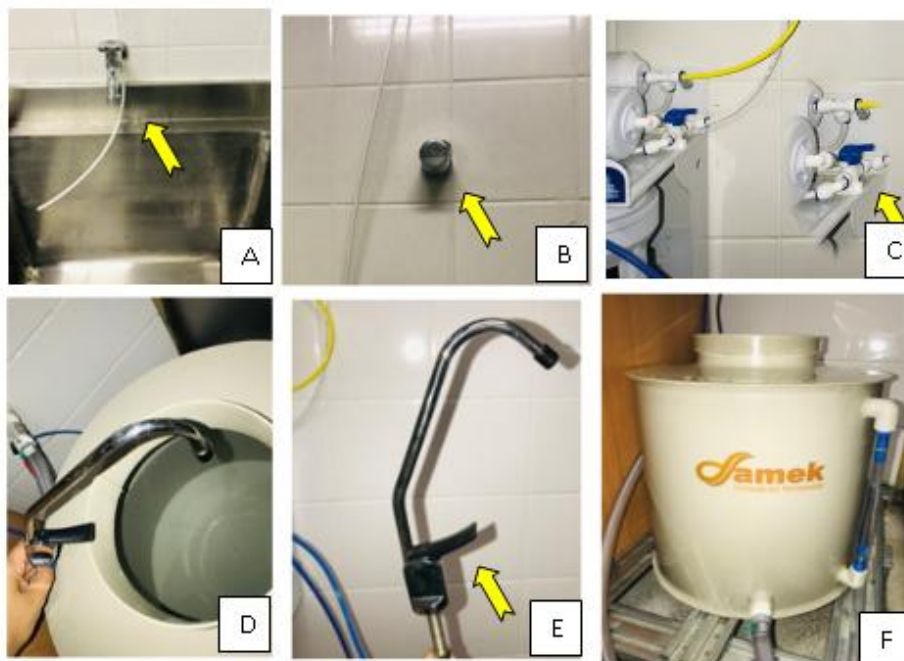
Figura 1 – A: Mangueira branca de drenagem; B: Registro geral; C: Registro de saída de água da Osmose; D: Local para posicionar torneira da osmose; E:Válvula de saída de água destilada; F: Reservatório de água destilada.
